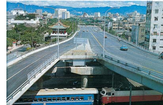
▲ 高架公路 Elevated highways
