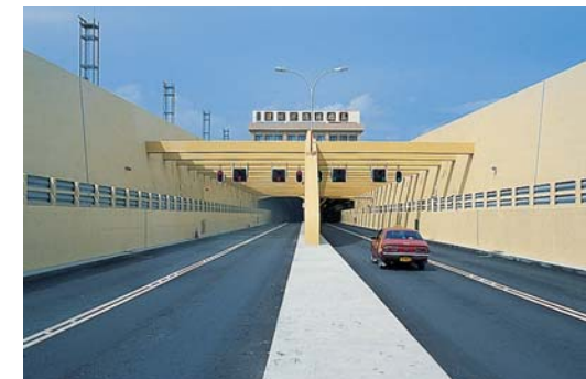
▲ 過港隧道 Tunnel under sea
